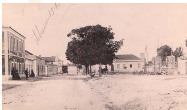
ROCIO ORIENTAL E CONSTRUÇÃO DO NOVO HOSPITAL
