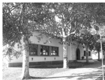
CANTINA DA ESCOLA PRIMÁRIA DE GRÂNDOLA
